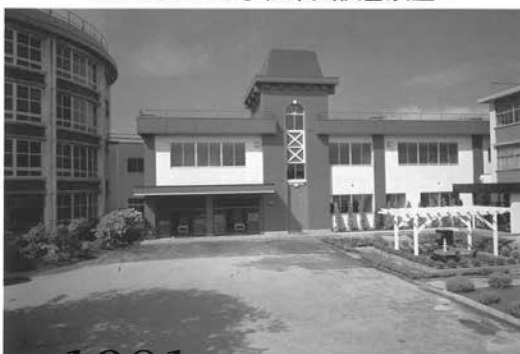
竹田女子高等学校中央校舎竣工
